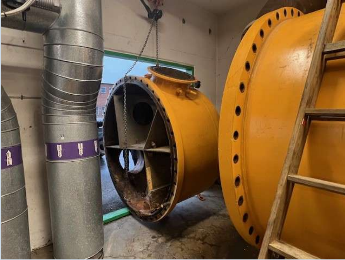
Ind- & udløbskammer løftes ud
