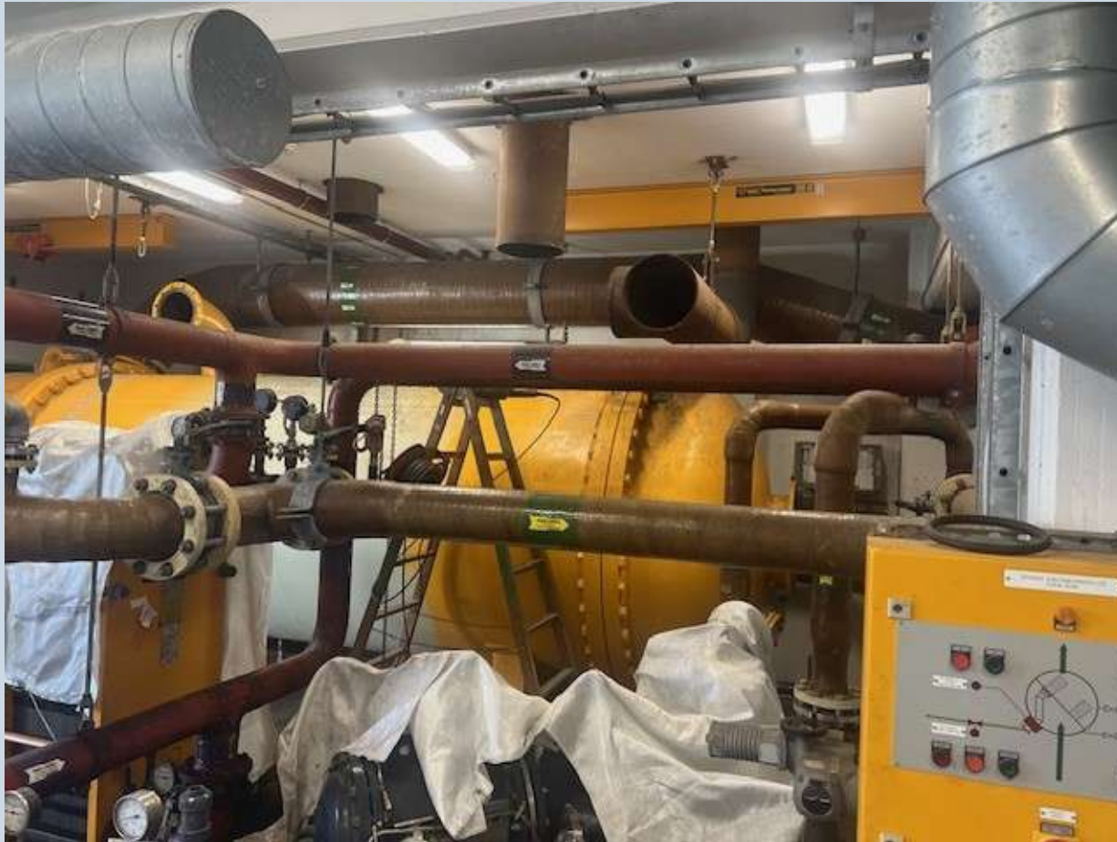
Rør til gartneriveksler skæres ned
