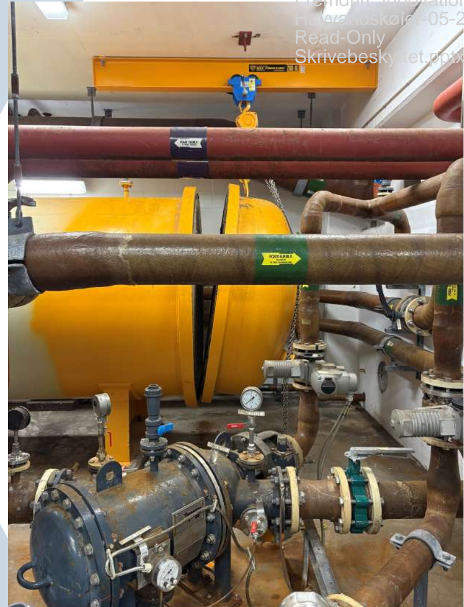
Demontering af vendekammer
