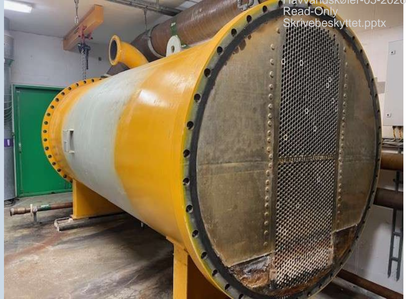
Titaniumsrør saltvandsside
