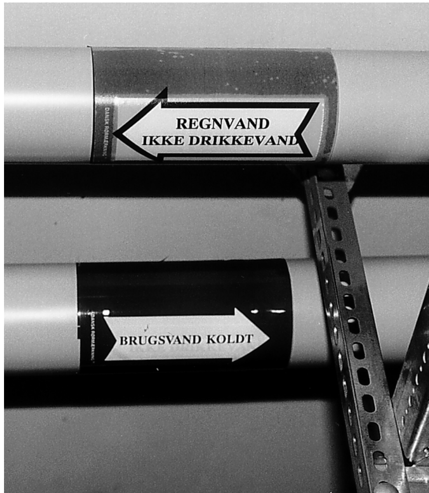
Figur 9.8 Mærkning af regnvandsledning og drikkevandsledning
