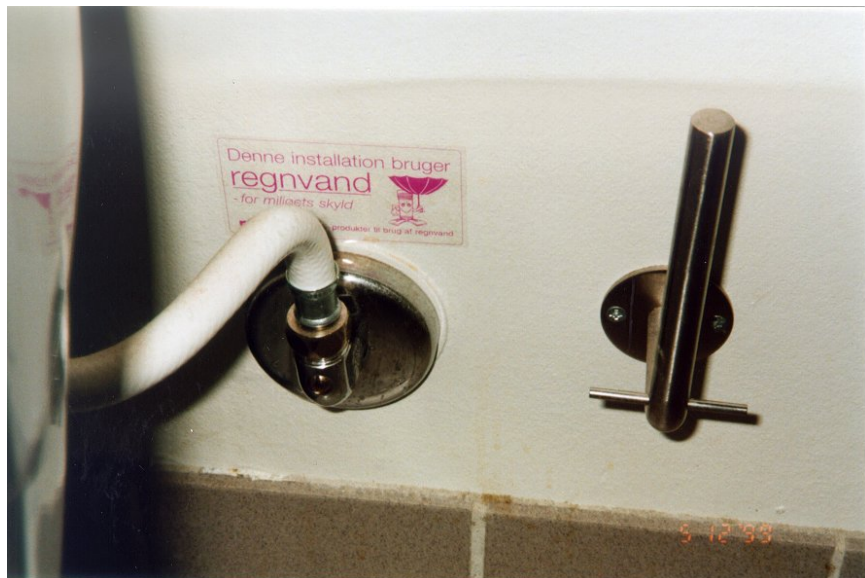
Figur 9.9 Mærkat der angiver, at der anvendes regnvand i denne installation.
