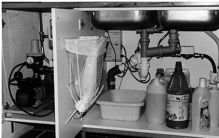
Figur 9.4 Styringsystem og pumpe anbragt under vask.
