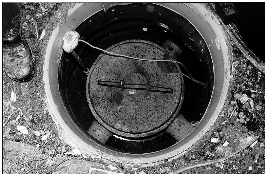
Figur 9.3 Regnvandstank med 2 tilløb og efterfyldning
